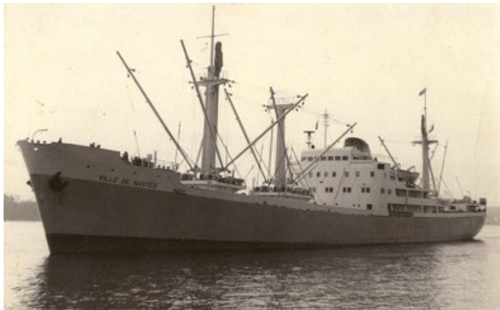
Le "Ville de Nantes". 138,00x 18,30x10,87 m - TE 7,89 m - JB 7 130 - JN 4 171 - PL 8 908 t - P 6 250 ch (4 600 kW) - Mot. B&W - V 15 nds - Cap. GRN 12 310 m3 (cinq cales / deux citernes à vin / une citerne à mélasse) - Mâts de charge 12 x 10 t - Bigues 30 t et 50 t.
