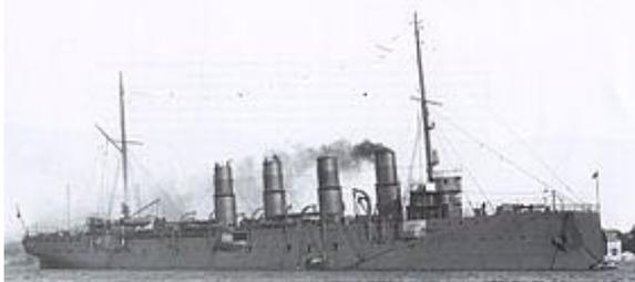
Croiseur protégé de 1re classe Châteaurenault lancé le 21 mai 1898 au chantier naval des forges et chantiers de la Méditerranée à La Seyne-sur-Mer. Longueur 135m - Maître-bau 17m - Tirant d'eau 7,39m - Déplacement 7898 tjb - Puissance 23000cv - Vitesse 23 nœuds.
